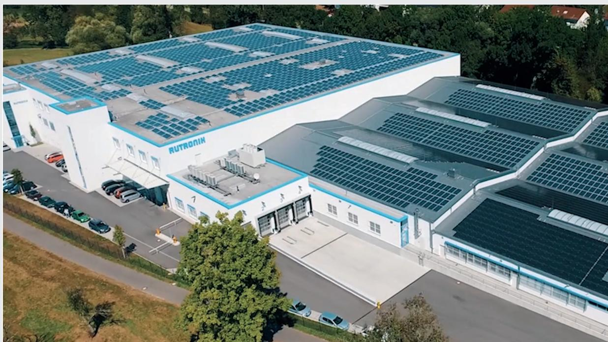
Industrie 4.0 in Aktion: Das automatisierte Lager für integrierte Logistiksysteme. Die auf allen Gebäuden installierte Gesamtleistung an photovoltaisch erzeugtem Strom beträgt ca. 1 MWp und spart jährlich 600 bis 700 Tonnen CO<sub>2</sub> ein.
